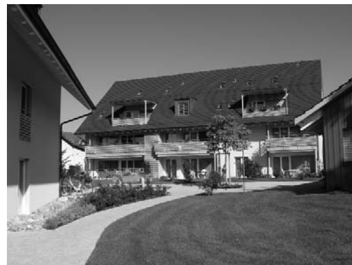
Blick auf ein Haus der Siedlung Emdwis
