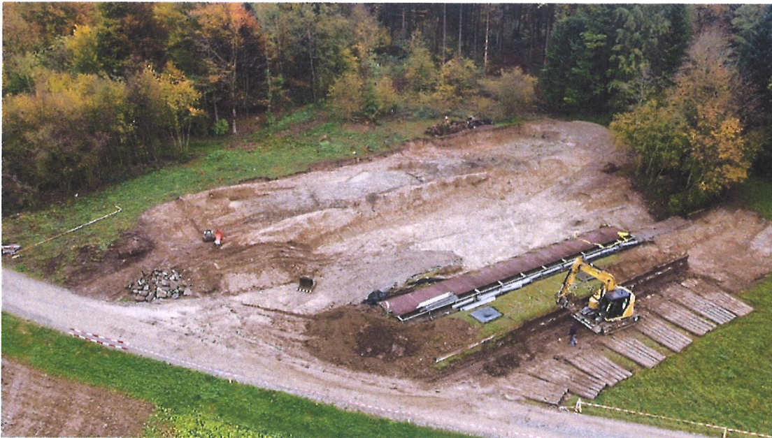
Bild Baustelle vom Oktober 2024
