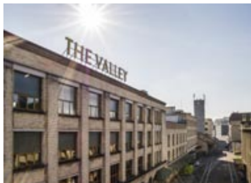
Die Sanierung und Wiederbelebung des industriehistorischen Maggi-Areals
