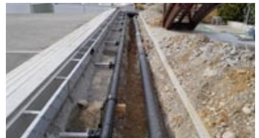
Auch die Leitungen sind verlegt.
