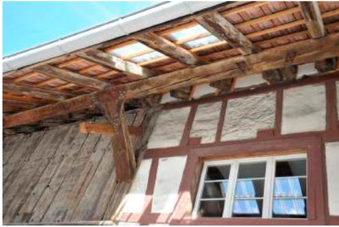
0191 Detail der Vordachkonstruktion
