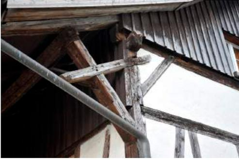
0253 Detail Vordachkonstruktion
