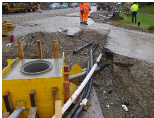
Im Zuge der Bauarbeiten an der Markwalderkreuzung in Tagelswangen wurde auch Strassenbeleuchtung saniert. Versorgungsschacht für die Stromversorgung der Strassenbeleuchtung und der Signalisationsanlage.
