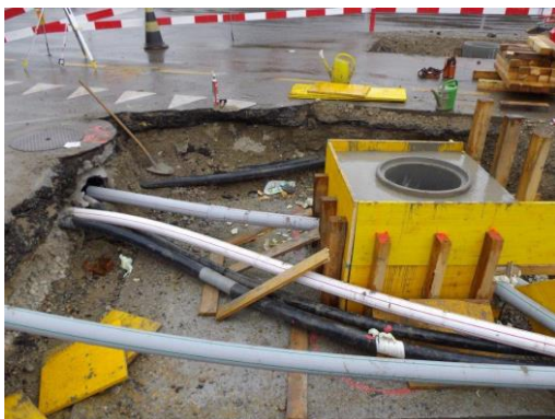
Im Zuge der Bauarbeiten an der Markwalderkreuzung in Tagelswangen wurde auch Strassenbeleuchtung saniert. Versorgungsschacht für die Stromversorgung der Strassenbeleuchtung und der Signalisationsanlage.
